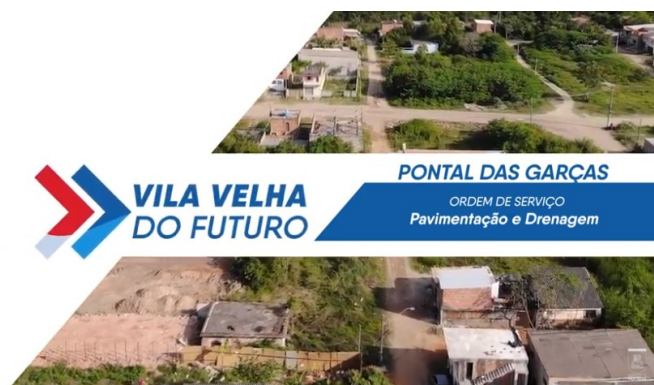
Obras de Drenagem e Pavimentação em Pontal das Garças 15
