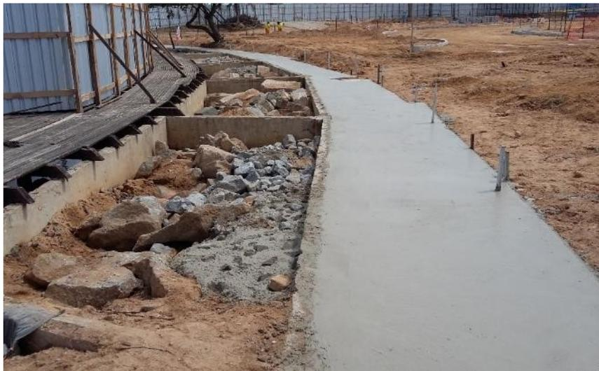
Foto 11- Concretagem da contenção de erosão nos decks
