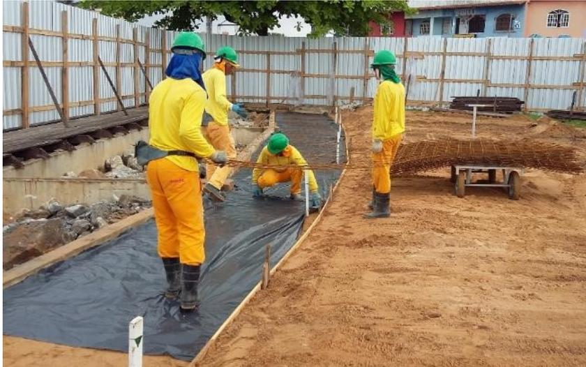
Foto 6- Concretagem da contenção de erosão nos decks – lona sobre o solo compactado.
