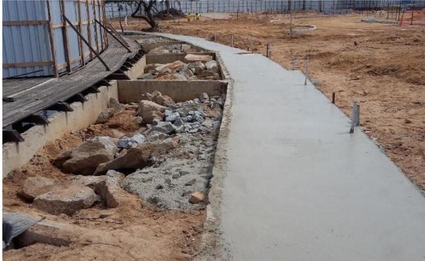
Foto 8- Concretagem da contenção de erosão nos decks
