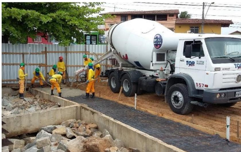
Foto 7- Concretagem da contenção de erosão nos decks
