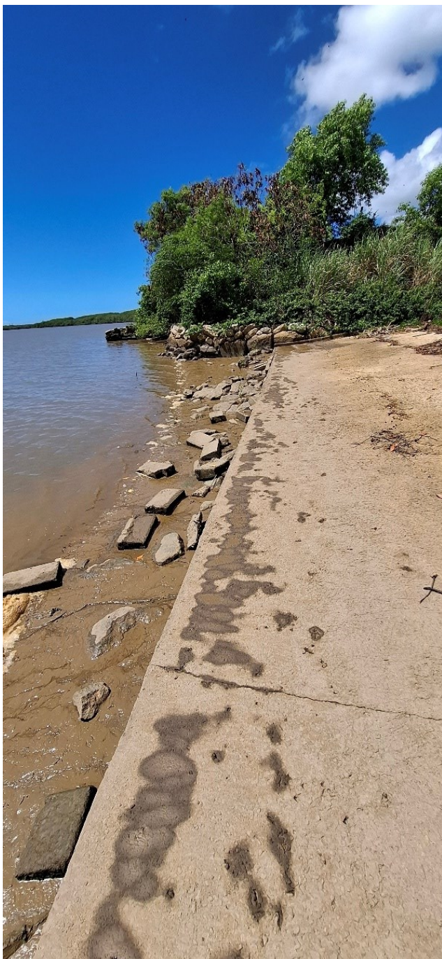
Deterioração da laje de embarque na margem norte (esquerda).
