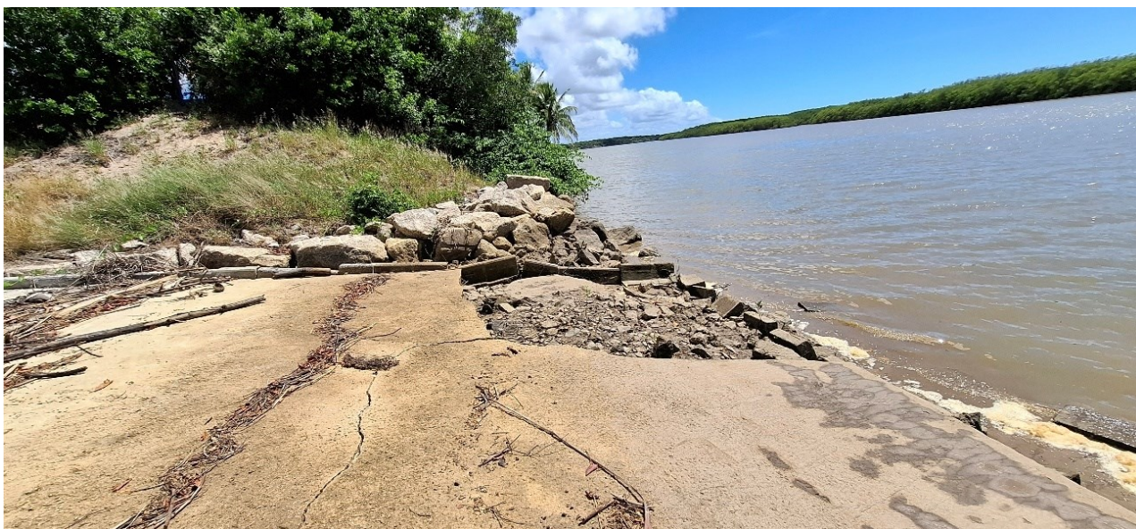
Deterioração da laje de embarque na margem norte (esquerda).
