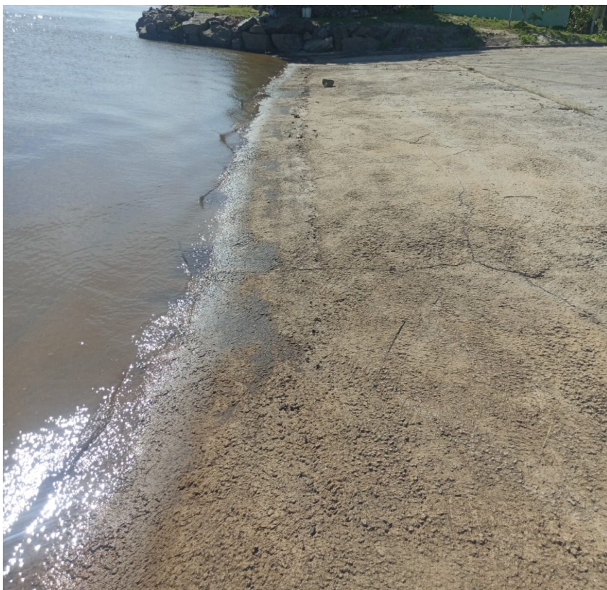
Fissuras em laje para acesso ao atracadouro sul (margem direita)
