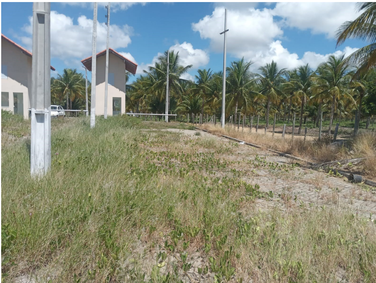
Necessidade de capinação no piso intertravado – margem norte (esquerda)
