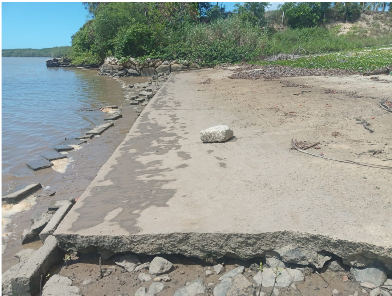
Deterioração da laje de embarque na margem norte (esquerda).
