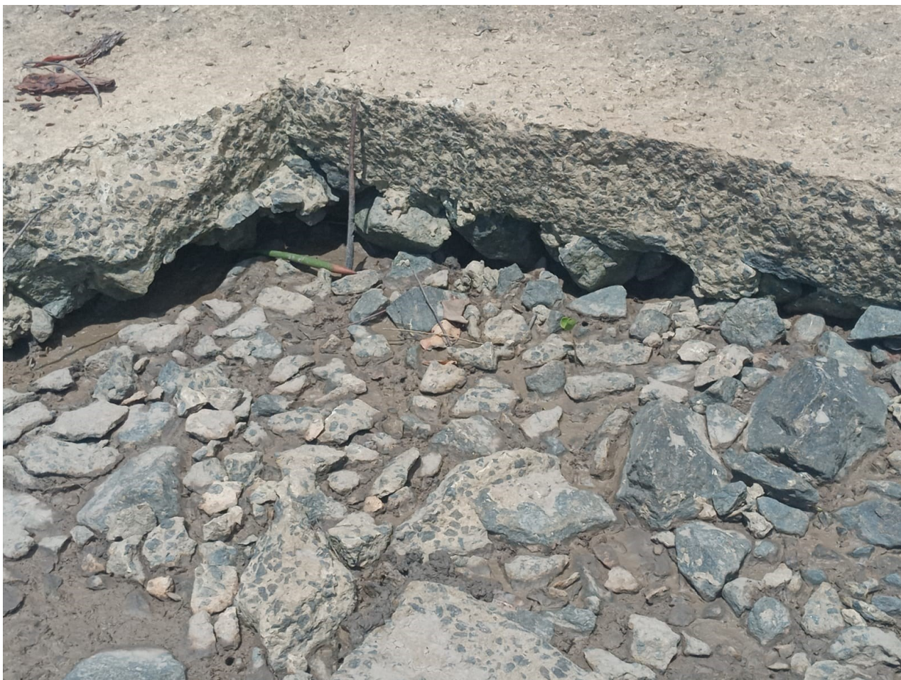
Ausência de armadura e de material de suporte na laje de acesso ao atracadouro norte (margem esquerda)
